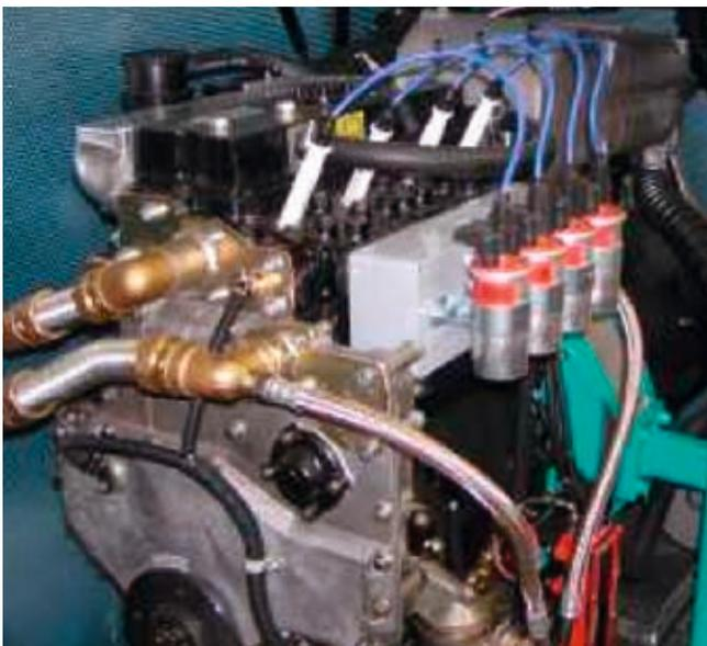
Bild 5: BHKW-Modul (Erdgasmotor mit Generator)
