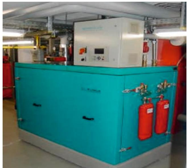
Bild 3: BHKW-Modul (Kompaktmodul mit Gehäuse)
