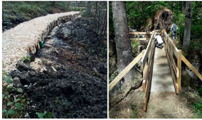
Viel zu tun haben die ehrenamtlichen Wegewart: So mussten am Schmelzplatz ein Bohlenweg erneuert und eine Brücke am Buselbachwasserfall instandgesetzt werden. Fotos: Schwarzwaldverein
